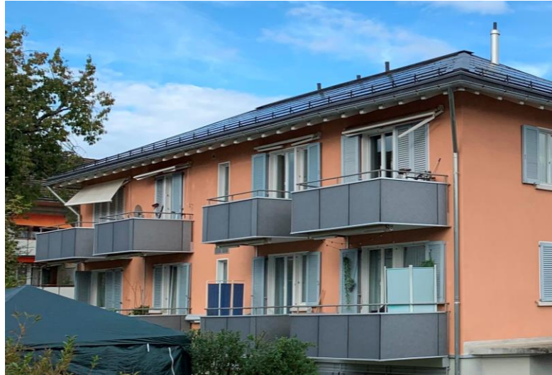
Nach der Sanierung: Mit Erdgas Einsparung von knapp 90 %; mit Biogas 100 % Reduktion des CO 2
